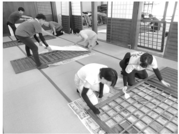
修徳殿障子張り
