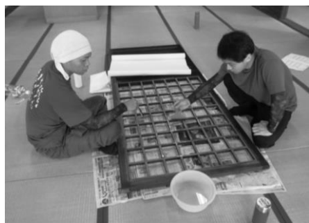
修徳殿障子張り
