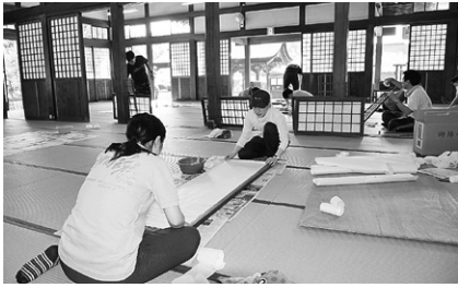
修徳殿障子張り
